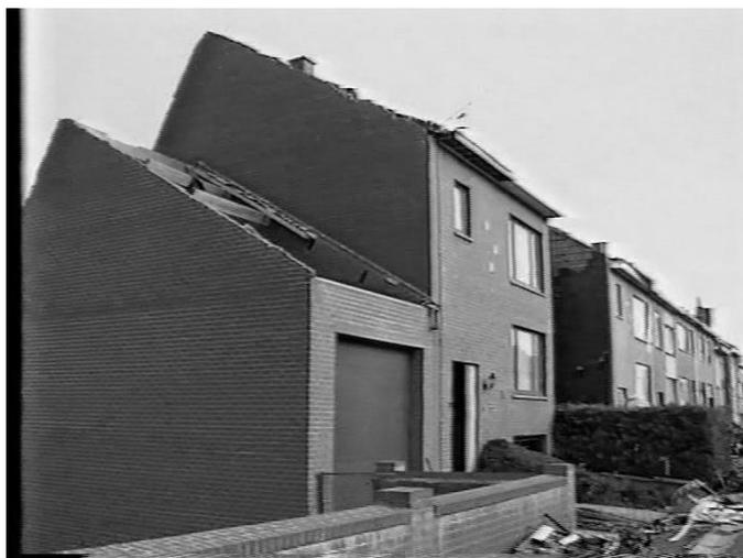
On voit ici en effet que la toiture du garage a été complètement soufflée ainsi que des morceaux de la charpente.
