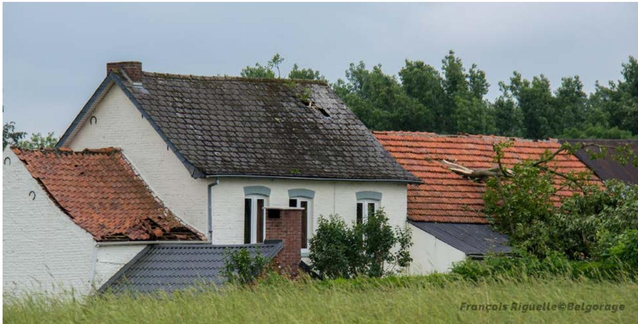
Dommmages sur les toitures de la ferme (7). Outre les tuiles et ardoises envolées, des branches, parfois massives, issues du verger, sont venues transpercer les toitures.
