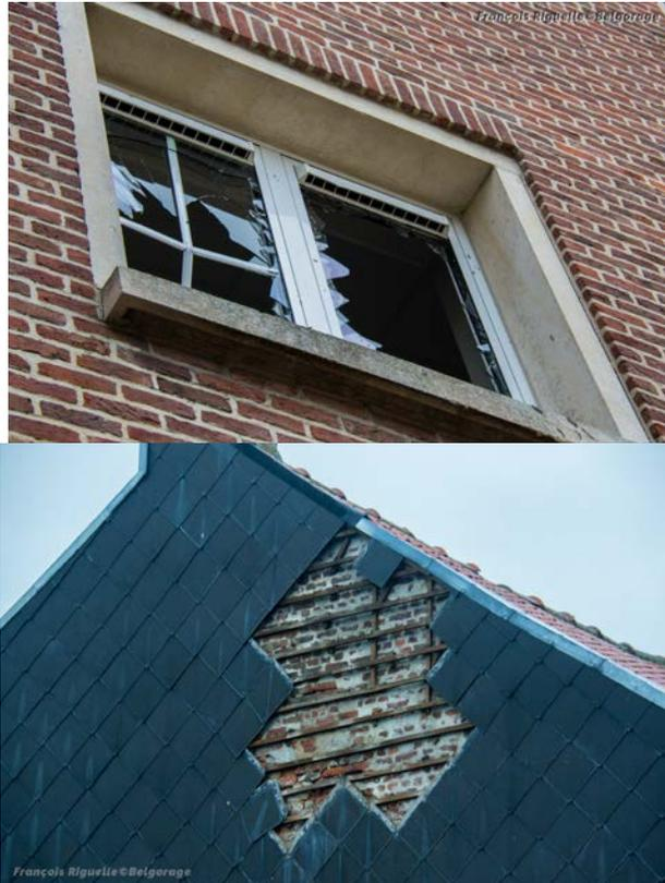
Exemples d'autres dégâts souvent rencontrés : des vitres brisées ainsi que des couvertures de façade en ardoises en parties envolées (25).
