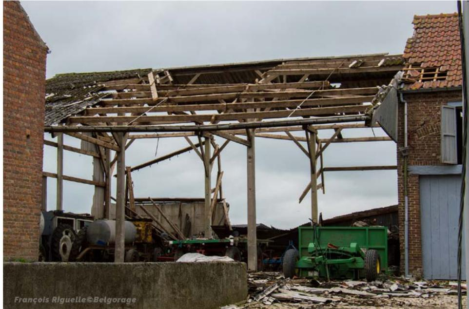
Hangar agricole (5) fortement endommagé. De nombreuses tôles ondulées se sont envolées ainsi que des éléments de charpente. Le mur du fond s'est aussi effondré tandis que les deux toitures des bâtiments visibles de part et d'autre du hangar ont vu de nombreux trous apparaître à la suite de tuiles déplacées. Le hangar s'écroulera même quelques semaines plus tard.
