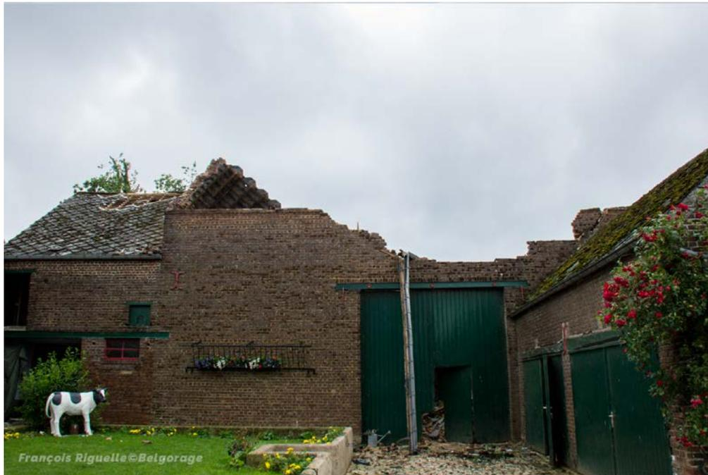
Toiture d'une grange (4) entièrement détruite par la rafale descendante. Des murs se sont également effondrés en partie.
