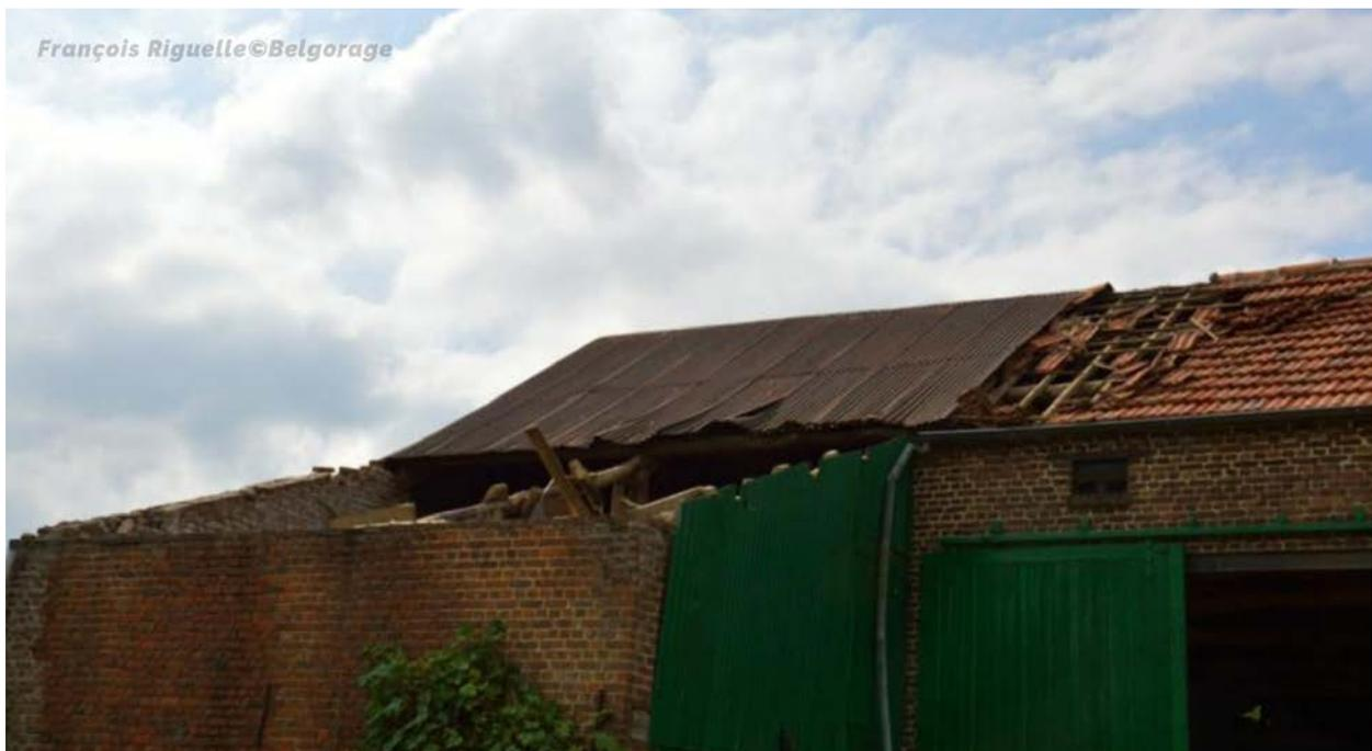
La même ferme (7) vue de l'autre côté, celui protégé du vent. On remarque toutefois que les toitures sont endommagées et l'une d'entre elles s'est même complètement envolée. Ces dommages sont causés par un phénomène d'aspiration causé possiblement par une basse pression due au passage de fortes rafales au-dessus.
