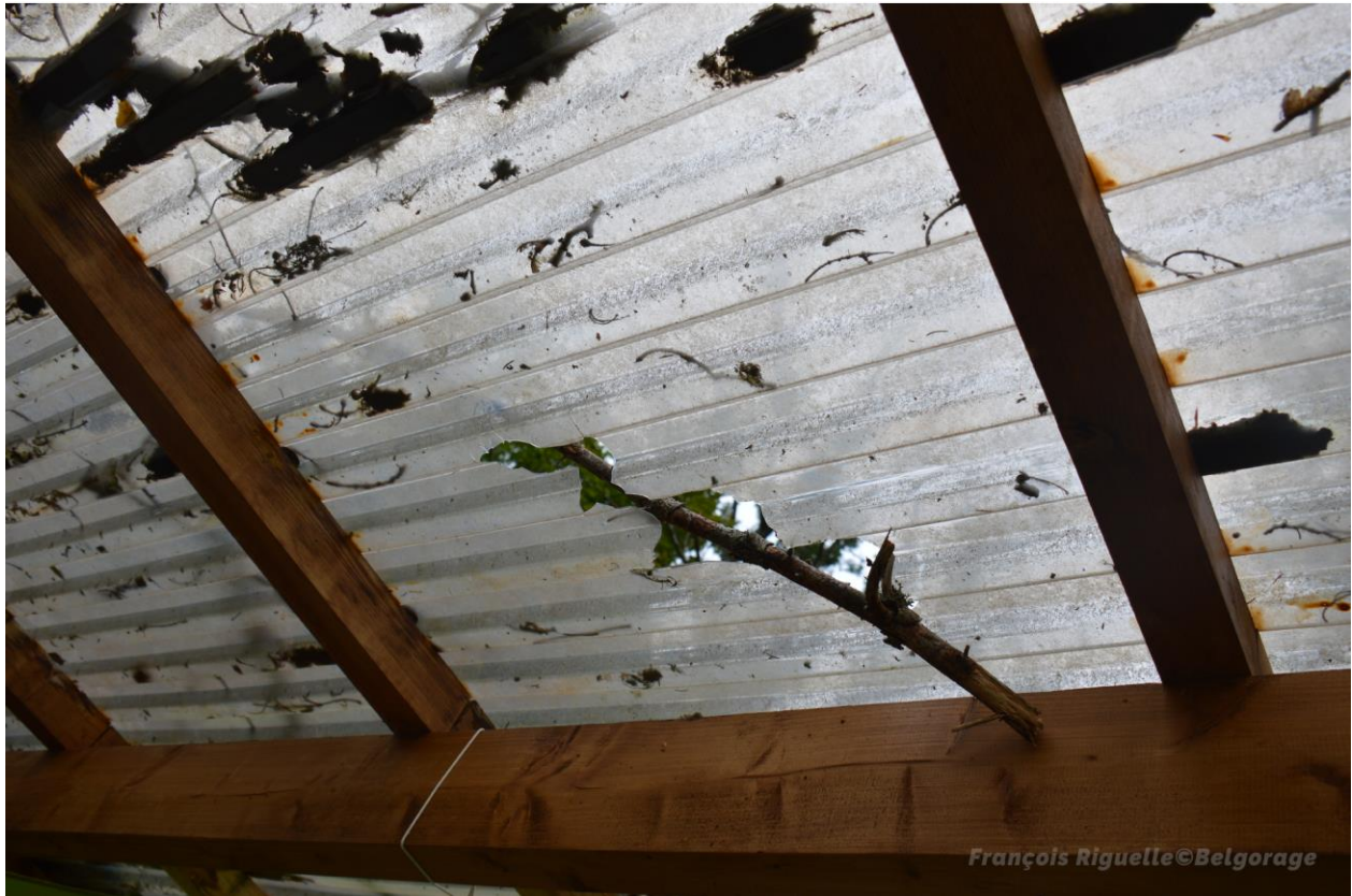
Véranda transpercée par des branches au camping de Les Hayons.
