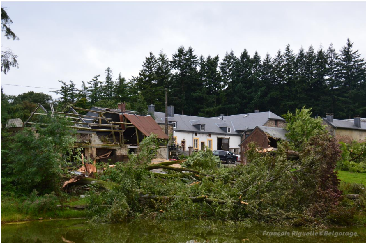
Vue générale de la zone. Nous pouvons voir les arbres abattus ainsi que le hangar qui a sa toiture en grande partie envolée (sur la gauche).
