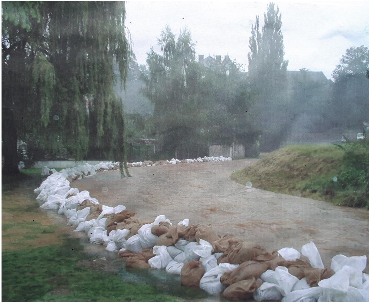
Protections contre les inondations érigées par l'armée à Jodoigne. Source : Ville de Jodoigne
