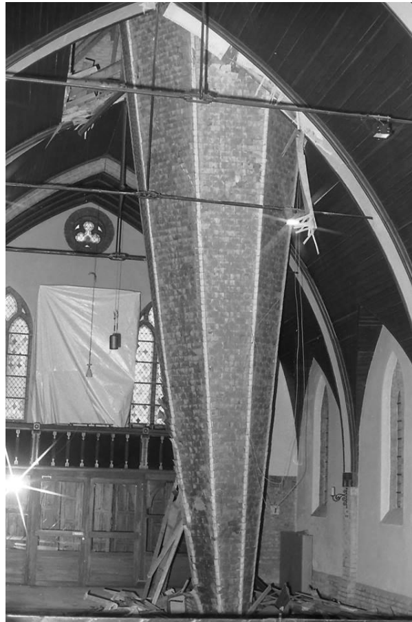
Source : archief Luc David (service incendie)
