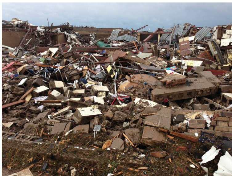
Dégâts à l'école de Briarwood Source: National Weather Service- Norman
